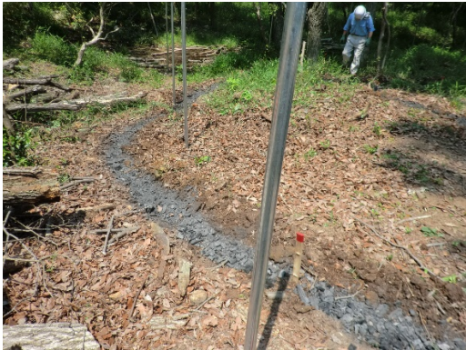
溝に粉炭を撒いて土で埋め戻し 炭の飛散を防ぎます
